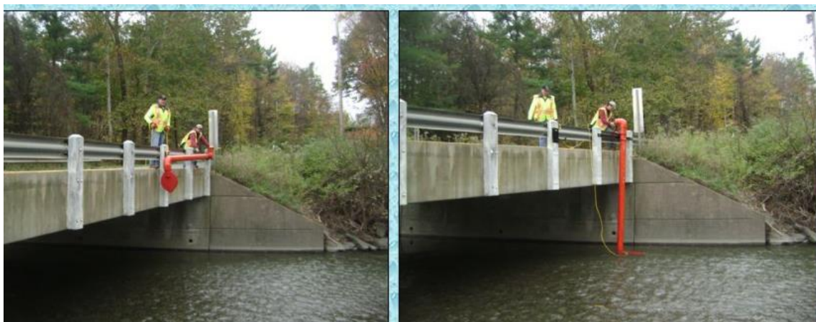
Figur 3 Exempel från USA. Förmonterat rör på broövergång för att Räddningstjänst ska kunna få tillträde till vattendrag
